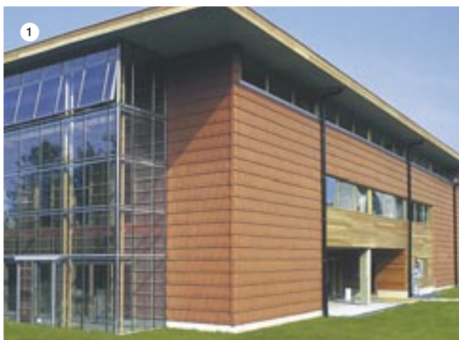
ACTUA MIGEON NATUURROOD evr-Architecten, arch. Luc Eeckhout, Jan Van Den Broecke en Luc Reuse - Gent
